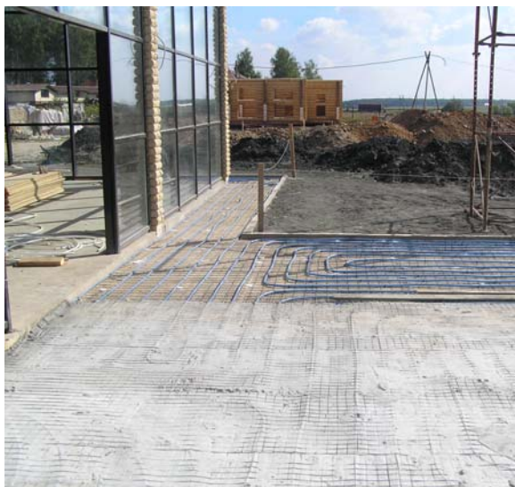
Рис.7 1. Гравий или песок 2. Бетонная плита 3. Трубы контуров снеготаяния В. Глубина укладки труб не более 120 мм. D. Бетонная плита (стяжка). Толщина и наличие слоя армирования в соответствии с требованиями нагрузки (50-200 мм). E. Гравийно-песчаная отсыпка. Толщина в соответствии с планируемой нагрузкой.
